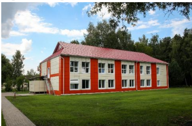
Фото 6.2.1. Коллекционно-экспериментальный корпус ФГБУ «ВНИИКР»
