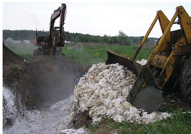
**Рис. 18. Тяжелая землеройная техника, устройство и заполнение ямы для захоронения**
