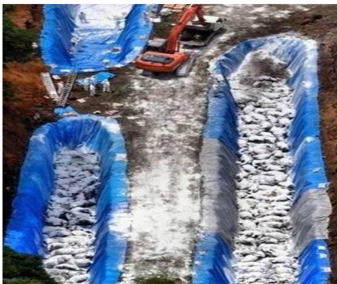
Фото 3. Траншеи, высланные водонепроницаемым материалом, в которых закапывался инфицированный скот в Японии.
